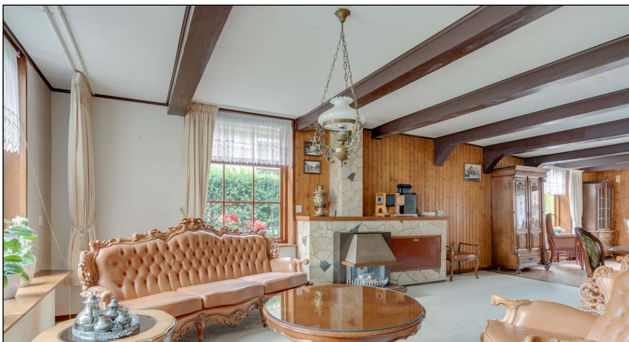
Afbeelding 11. Oude balklaag met korbelen in het westelijke bouwdeel. Bron: Funda.nl.
