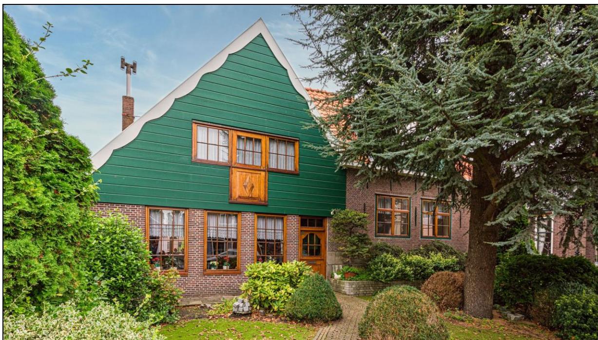
Afbeelding 10. Voorgevel van het pand. Rechts het bouwdeel met de grote kelder en opkamer. Bron: Funda.nl.
